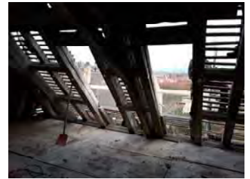
Retti-Palais: Gaubenausbau und Winterdach. © Förderverein 2018
