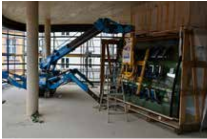
Der sogenannte „Manipulator“ hebt die Glasscheiben (Foto: Eugen Ringhand)
