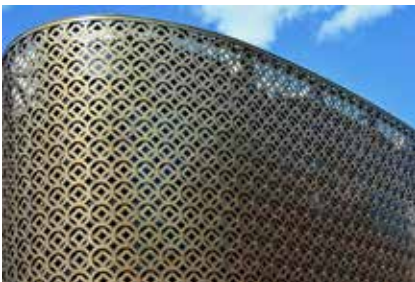
Detail der Fassade: Die Messing-Vorhangfassade. (Foto: Eugen Ringhand)
