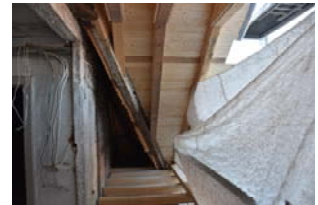
Oben: Südlicher Zierschornstein Unten: Errichteter Giebel im Walm
